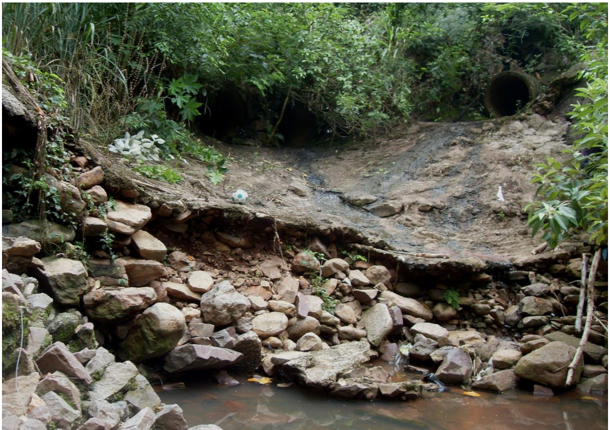
Figura 16 - Galerias de águas pluviais sem emissários no córrego Fantasmilha - Autor: Paulo J. Scapin
