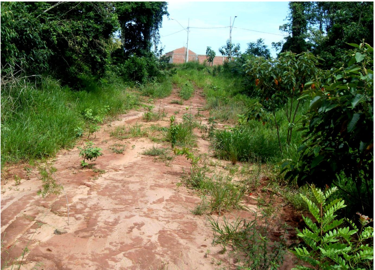
Figura 8 – Erosão laminar na trilha da galeria de esgoto pluvial do Jardim Itália com 400 m de extensão, compactada, erosiva e com invasoras - Autor: Paulo J. Scapin
